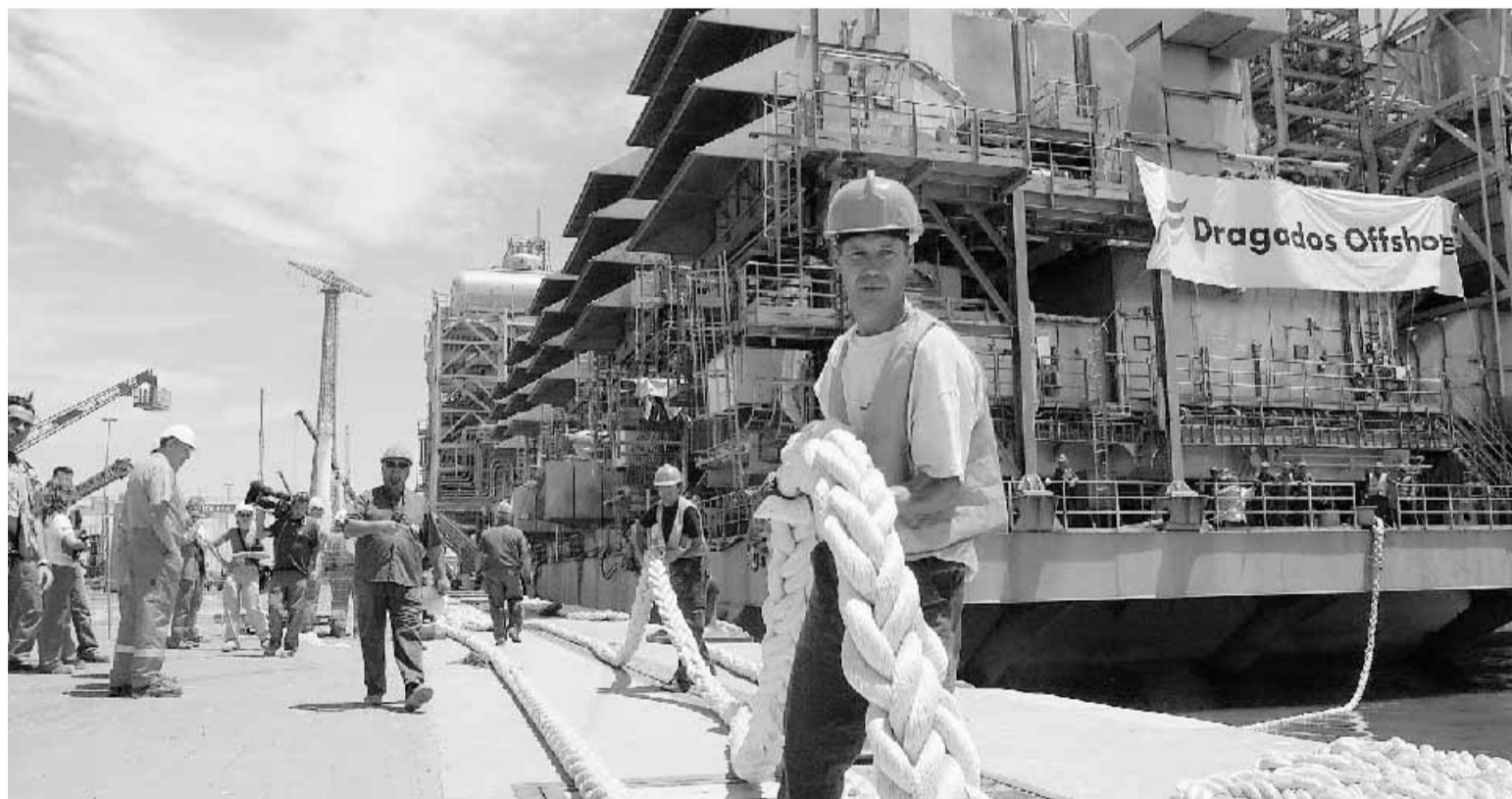
La empresa Dragados Offshore, que fabrica en Puerto Real plantas de gas, aprueba. :: ANTONIO VÁZQUEZ
